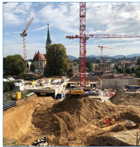
Edificio seminterrato sopra Kirchgarten
