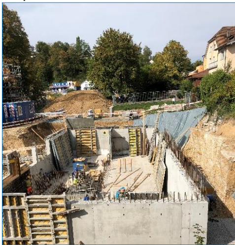
Scavo miscelazione serbatoio acqua ARA
