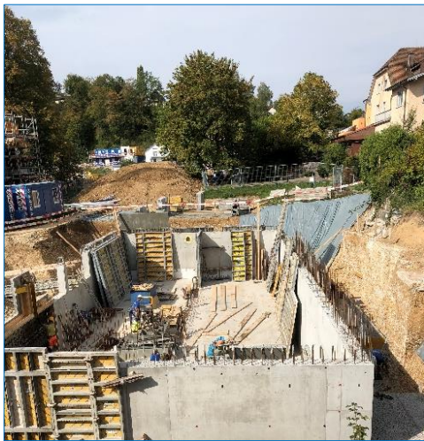
Aushub Mischwasserbecken ARA
